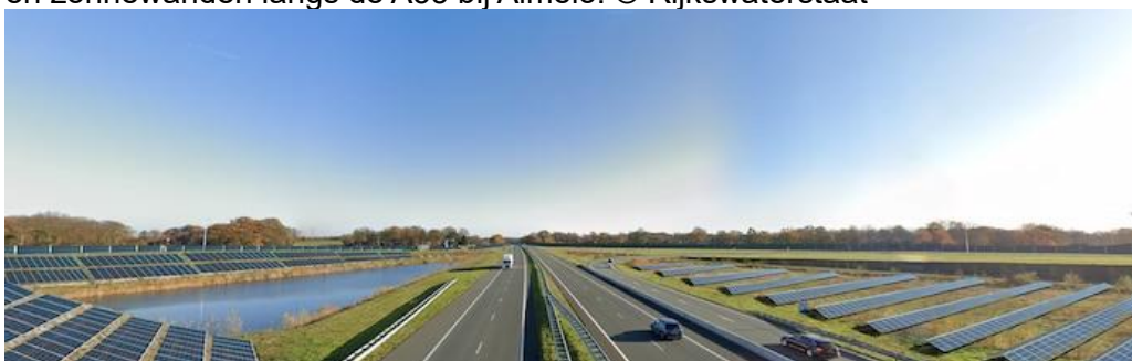
Het zonneveld in Enschede ter hoogte van de afrit Zuiderval. © Rijkswaterstaat
