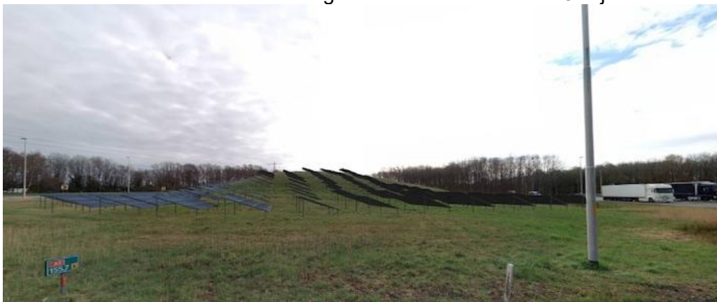
Panelen op een talud bij het knooppunt Buren bij Borne. © Rijkswaterstaat
